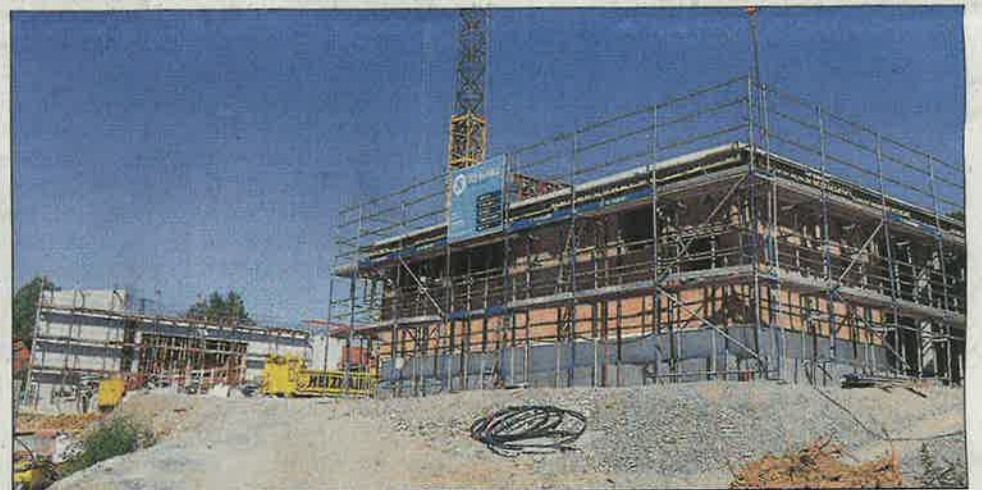
Die neue Eckenberghalle nimm Formen an: Im Vordergrund ist das künftige Foyer zu sehen.
