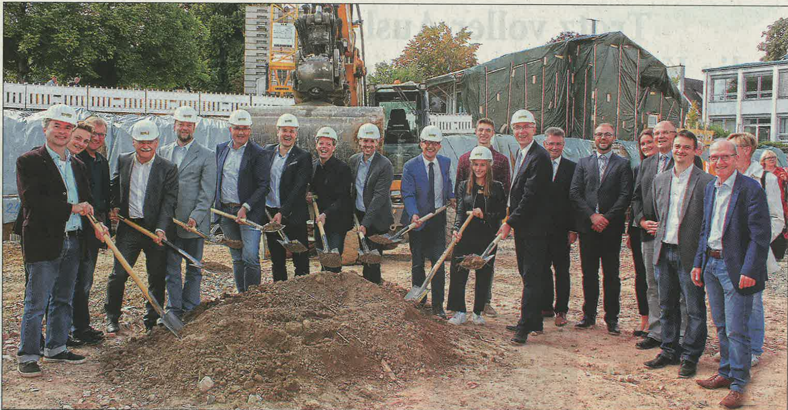
Nach dem „Baggerbiss“ wurde ganz traditionell zum Spaten gegriffen, um den Start des Umbaus des Burghardt-Gymnasiums, der 2022 abgeschlossen sein soll, zu feiern.
