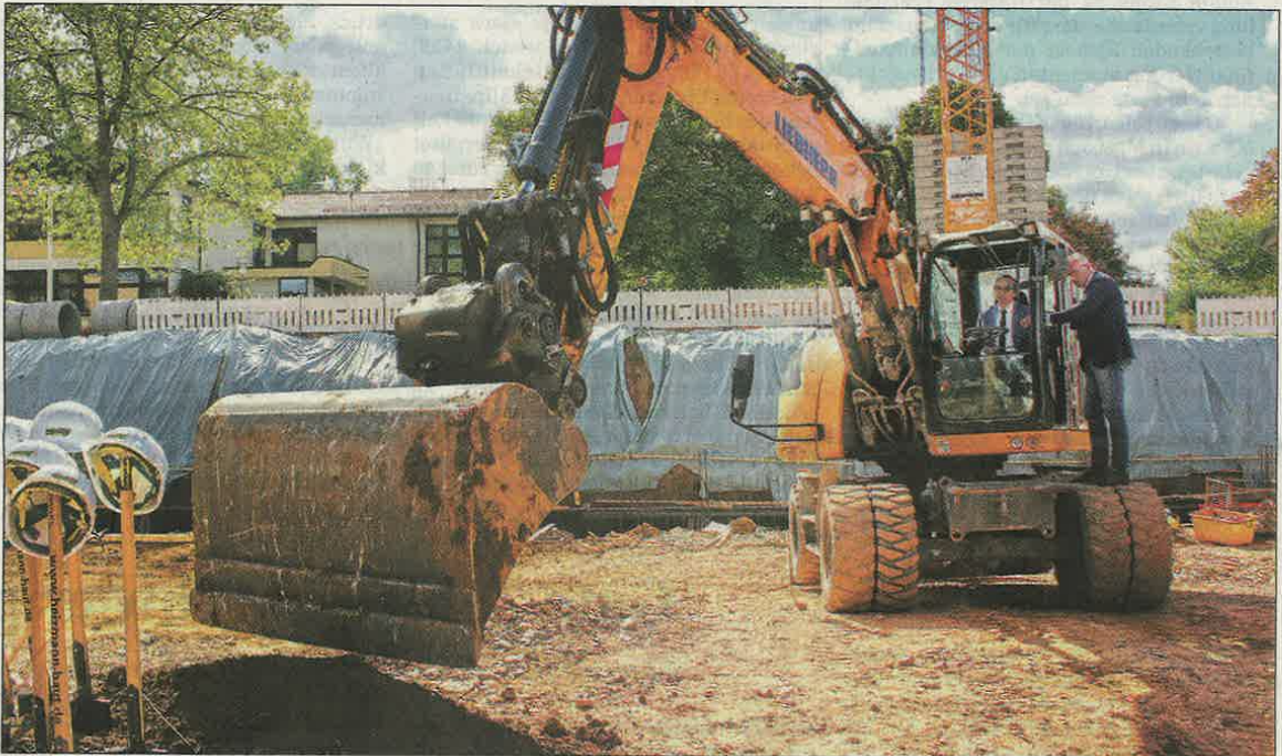
Mit einem symbolischen „Baggerbiss“ eröffnete Bürgermeister Roland Burger das Großprojekt „BGB-Sanierung“. Fotos: Tanja Radan
