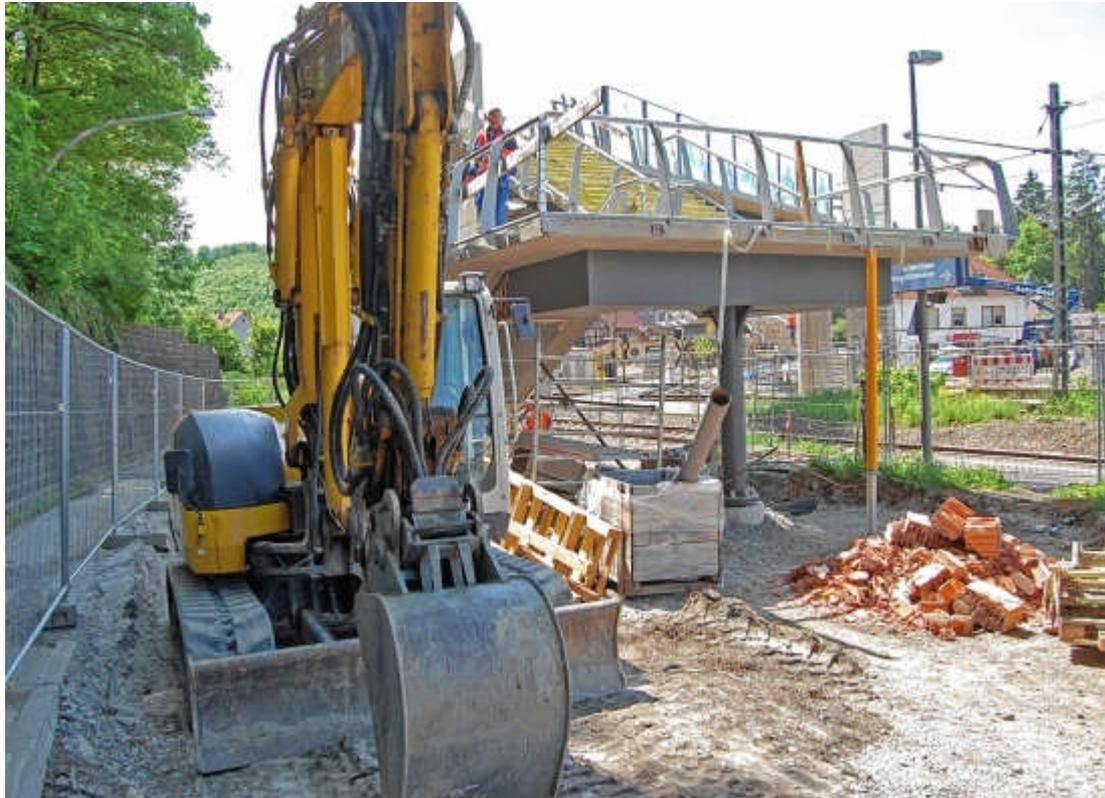
Der Bau der Fußgängerbrücke über die Gleise am Bahnhof Adelsheim-Ost kommt gut voran. Die Betonierarbeiten sind erledigt, so dass aktuell bereits die Stahlkonstruktion für die Auf- und Abgänge und das Geländer gefertigt werden. Dies wird nicht wie ursprünglich geplant aus geschliffenem Rohr, sondern aus länger haltbarem Edelstahl hergestellt.
