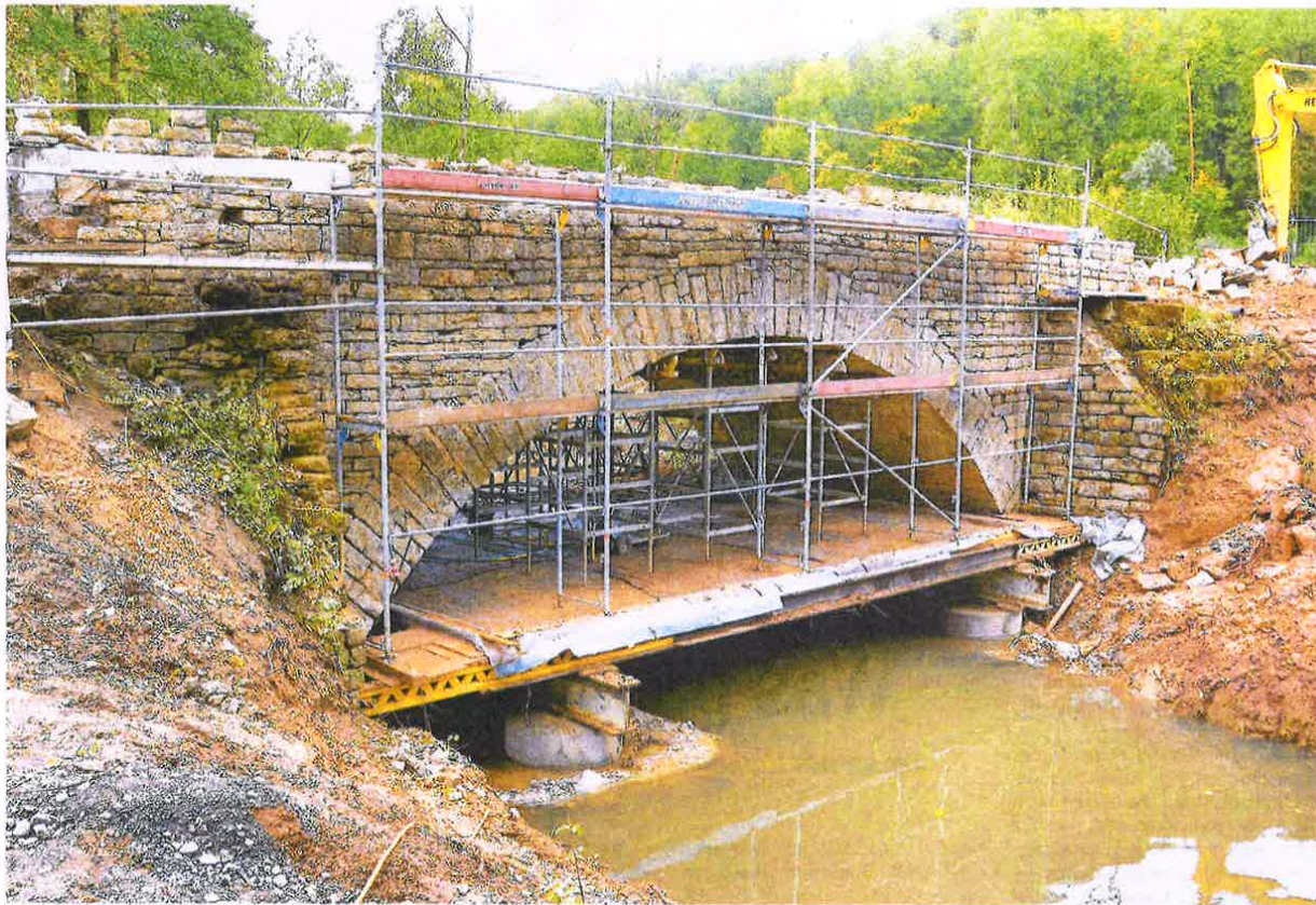
Die Bauleute der Firma Heizmann versetzen eine denkmalgeschützte Natursteinbrücke über die Schefflenz in Neudenua in einen sicheren Zustand.
