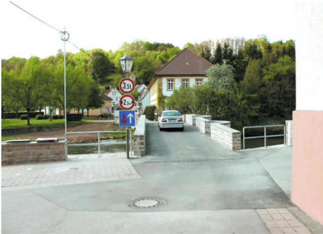
Seckachbrücke wieder befahrbar. Foto: J. Casel
