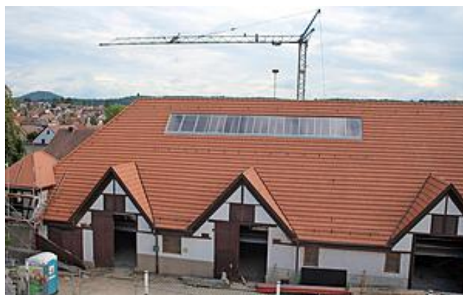
Blick vom gegenüberliegenden Wohn- und Geschäftshaus auf die Alte Kelter mit neuen Glasfenstern im Dach.
